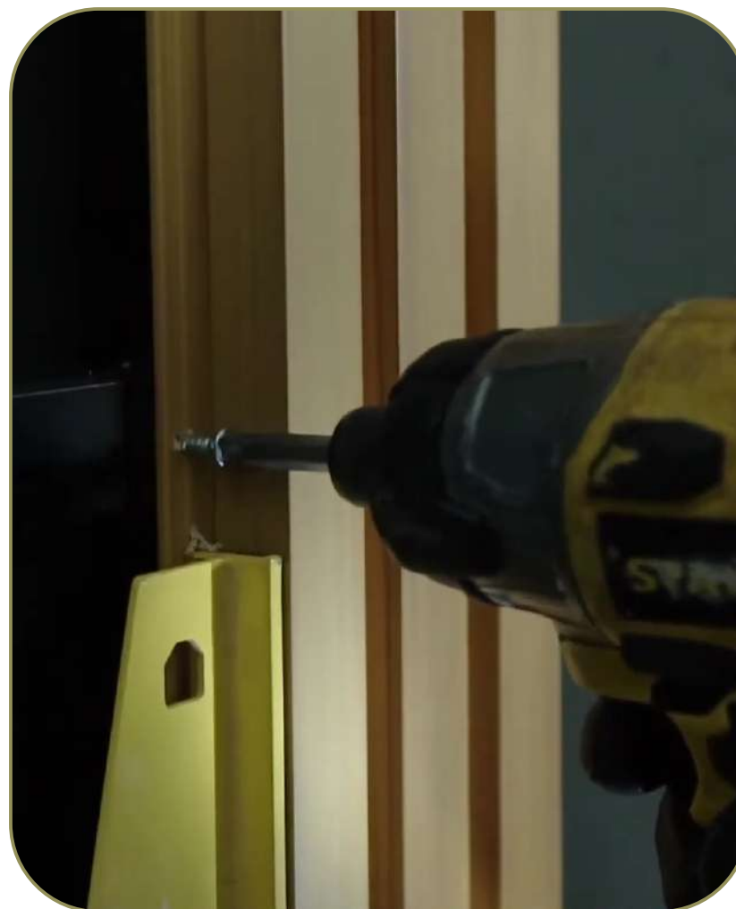
PARAFUSAÇÃO DAS SUBESTRUTURAS
