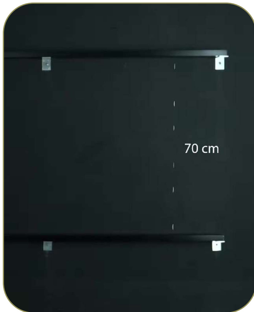
CALCULAR DISTANCIAMENTO ENTRE SUBESTRUTURAS
