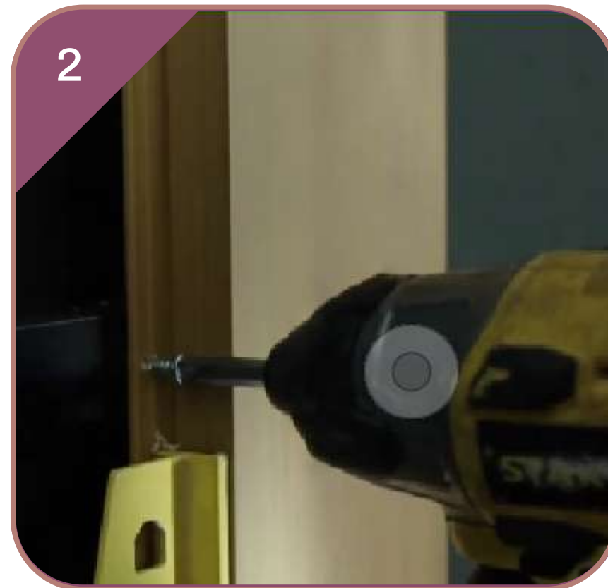
PARAFUSAÇÃO DAS CANTONEIRAS E APLICAÇÃO DOS PERFIS
