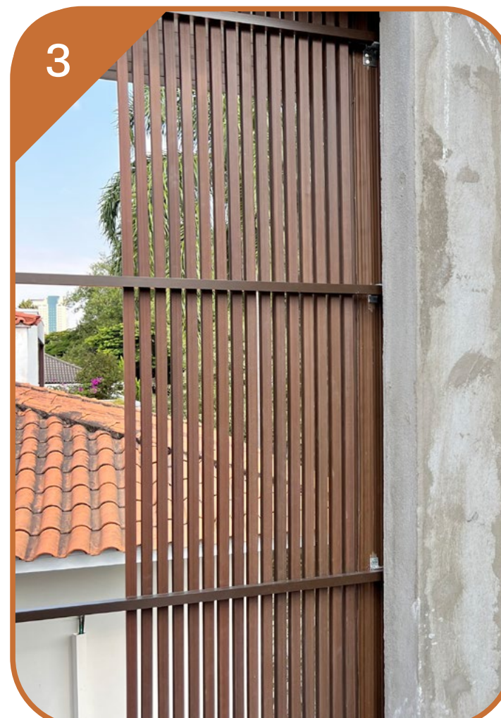
FIXAÇÃO NA ESQUADRIA / ALVENARIA
