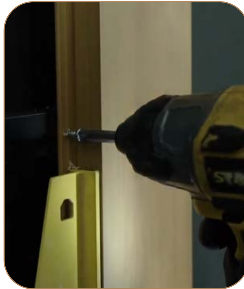
PARAFUSAÇÃO DAS CANTONEIRAS E APLICAÇÃO DOS PERFIS
