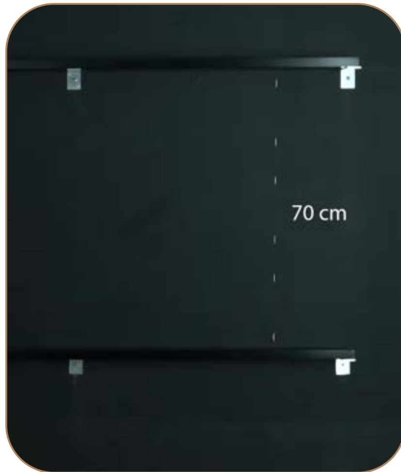
CALCULAR DISTANCIAMENTO ENTRE APOIOS
