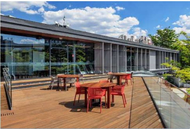
Edifício comercial, Arkodeck E, São Paulo, Brasil
