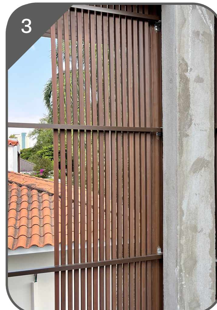
FIXAÇÃO NA ESQUADRIA / ALVENARIA
