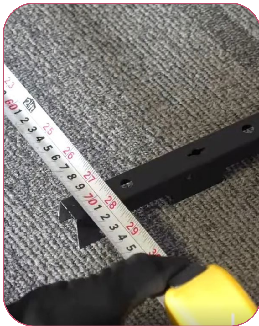
CALCULAR DISTANCIAMENTO ENTRE SUBESTRUTURAS
