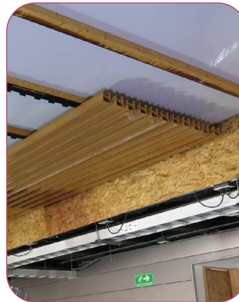
ENCAIXE DOS PERFIS NAS SUBESTRUTURAS
