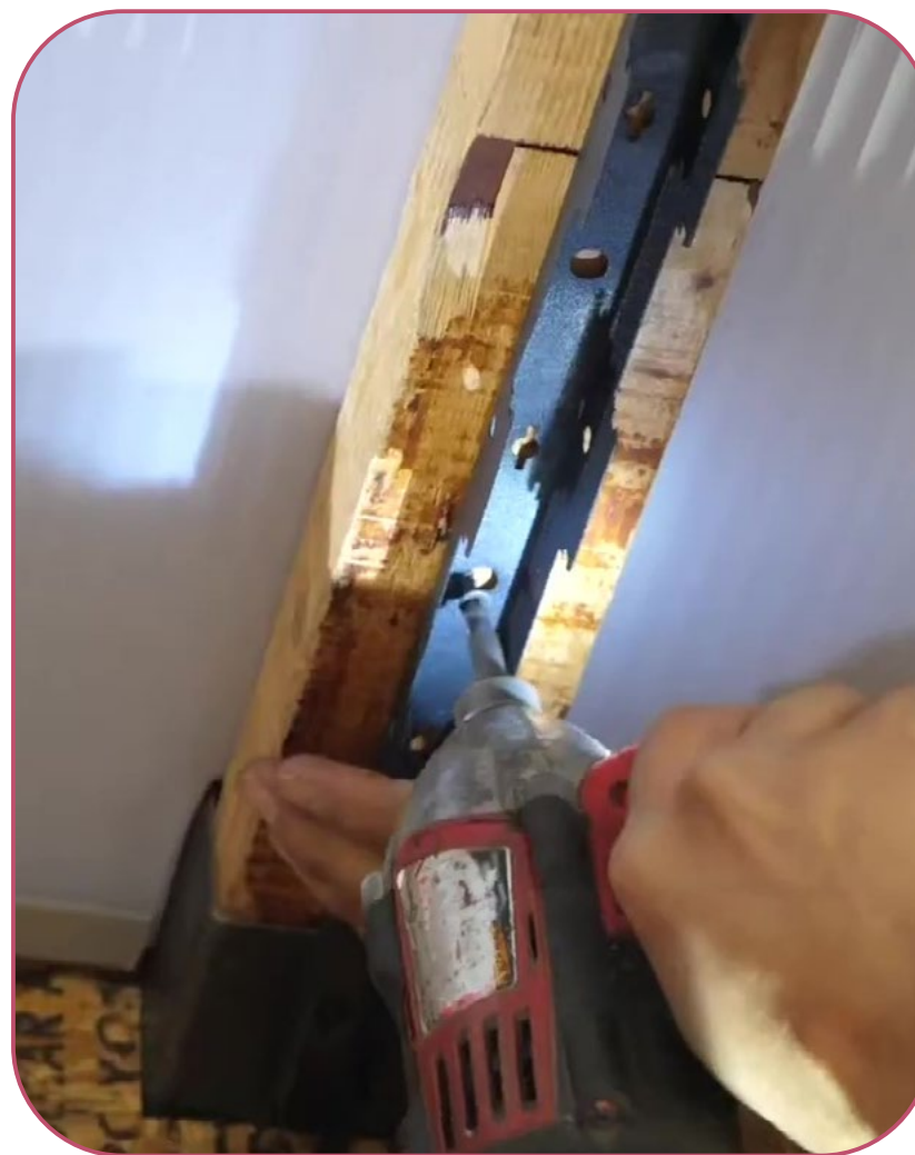
PARAFUSAÇÃO DAS SUBESTRUTURAS
