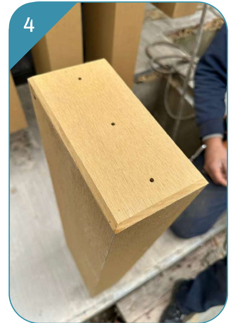
4 FIXAÇÃO DE TAMPAS COM DRENOS PARA VENTILAÇÃO
