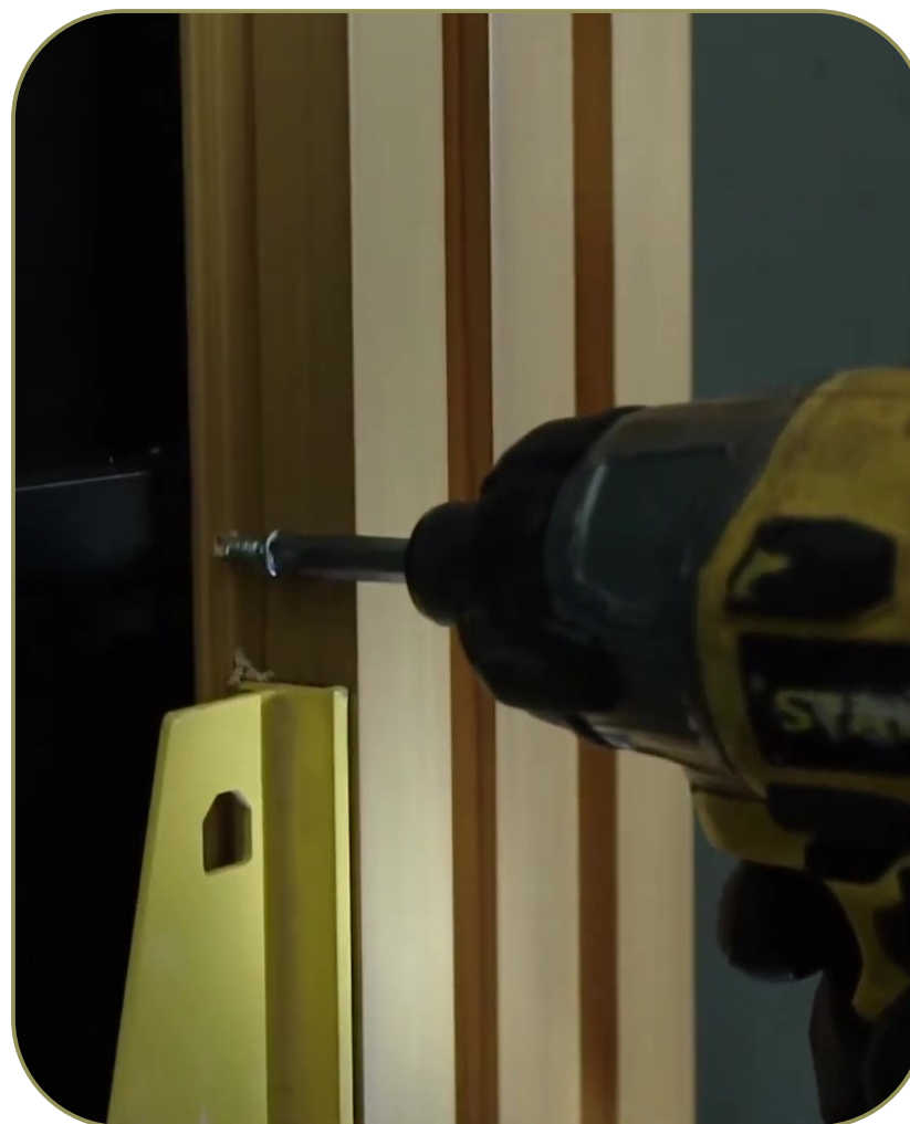
PARAFUSAÇÃO DAS SUBESTRUTURAS
