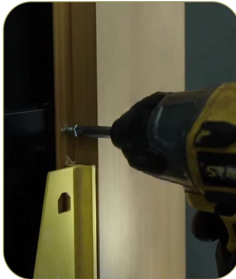
PARAFUSAÇÃO DAS CANTONEIRAS E APLICAÇÃO DOS PERFIS
