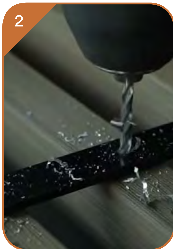
FIXAÇÃO EM BARRA CHATA METÁLICA
