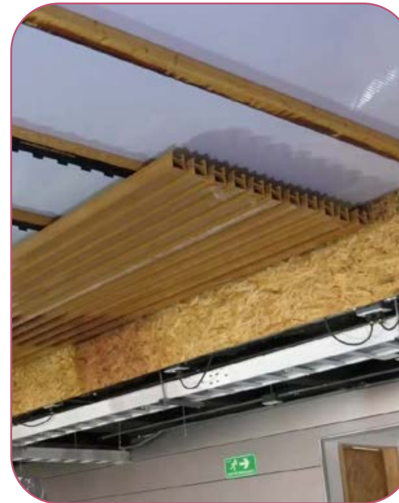
ENCAIXE DOS PERFIS NAS SUBESTRUTURAS
