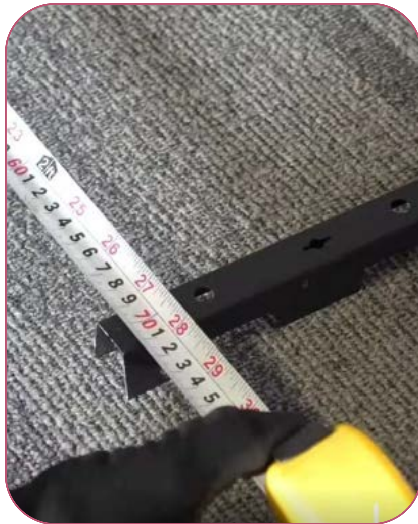
CALCULAR DISTANCIAMENTO ENTRE SUBESTRUTURAS
