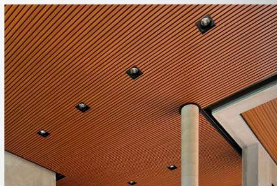
Casa RF. Arq.: Martini Arquitetura. Localização: Vinhedo, SP
